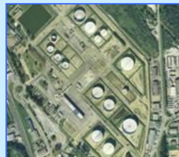
Dépôt pétrolier de Vern sur Seiche
