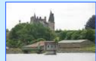
Barrage de la Valière
