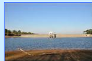
Barrage de la Chèze
