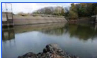
Barrage de Mireloup
