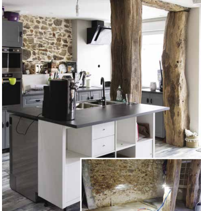
Après les travaux
